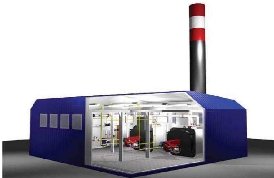
**Рис.1.1.1 «Блочно-модульная котельная»**
