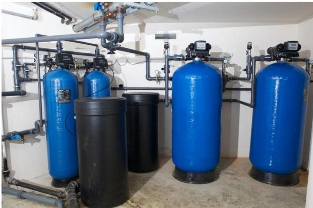
**Рис. 1.3.5.1 «Установка химводоподготовки»**
